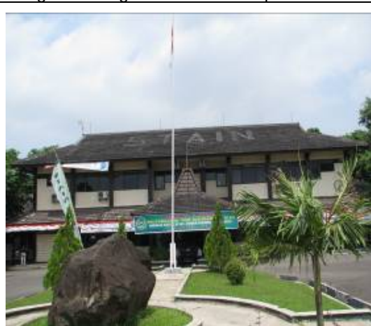
Tampak Depan Gedung STAIN Jember (Dept. Agama)
